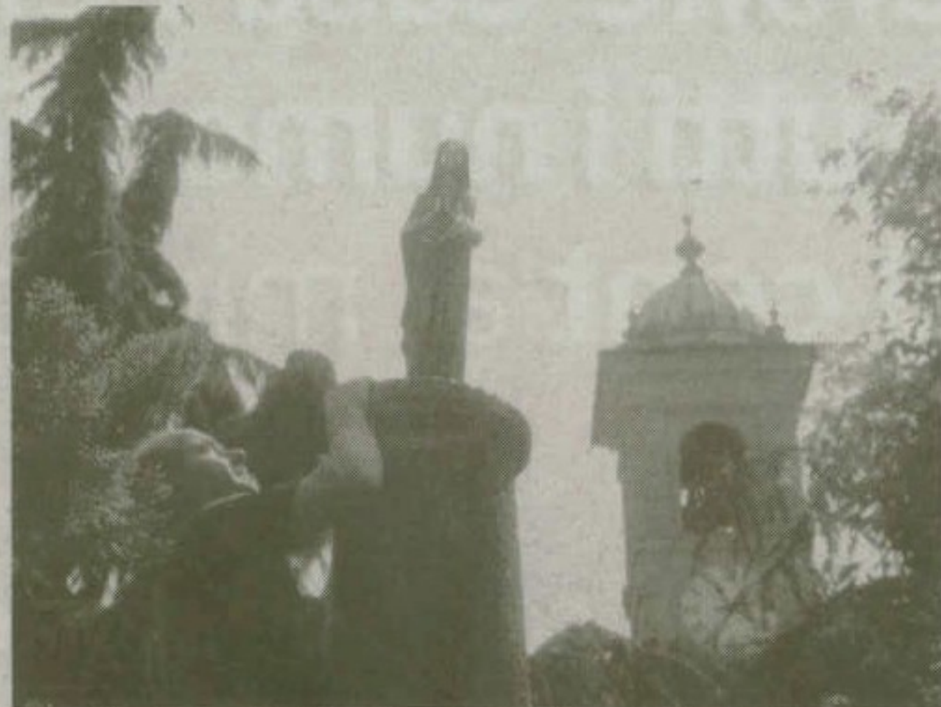
L'operazione di ancoraggio della statua della Madonna in cima alla colonna
